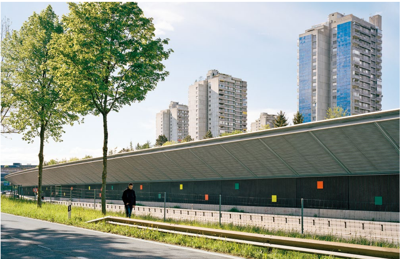
Autobahn-Lärmschutzwand bei Wittigkofen, Bern. Quelle: KEYSTONE/Gregory Collavini
