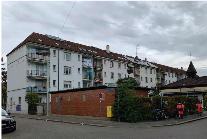
Ecke Rheinweilerweg / Schliengerweg
