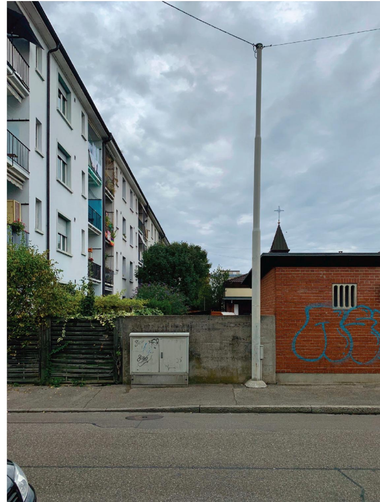
Hinterhofsituation mit Magazine Tiefbauamt
