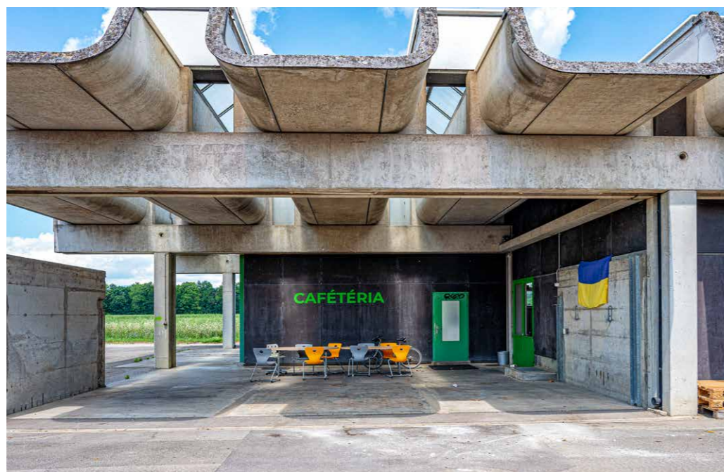
Die bestehenden denkmalgeschützten Gebäude im Gebiet des AgriCo werden im Moment zum Teil zwischengemischt.
