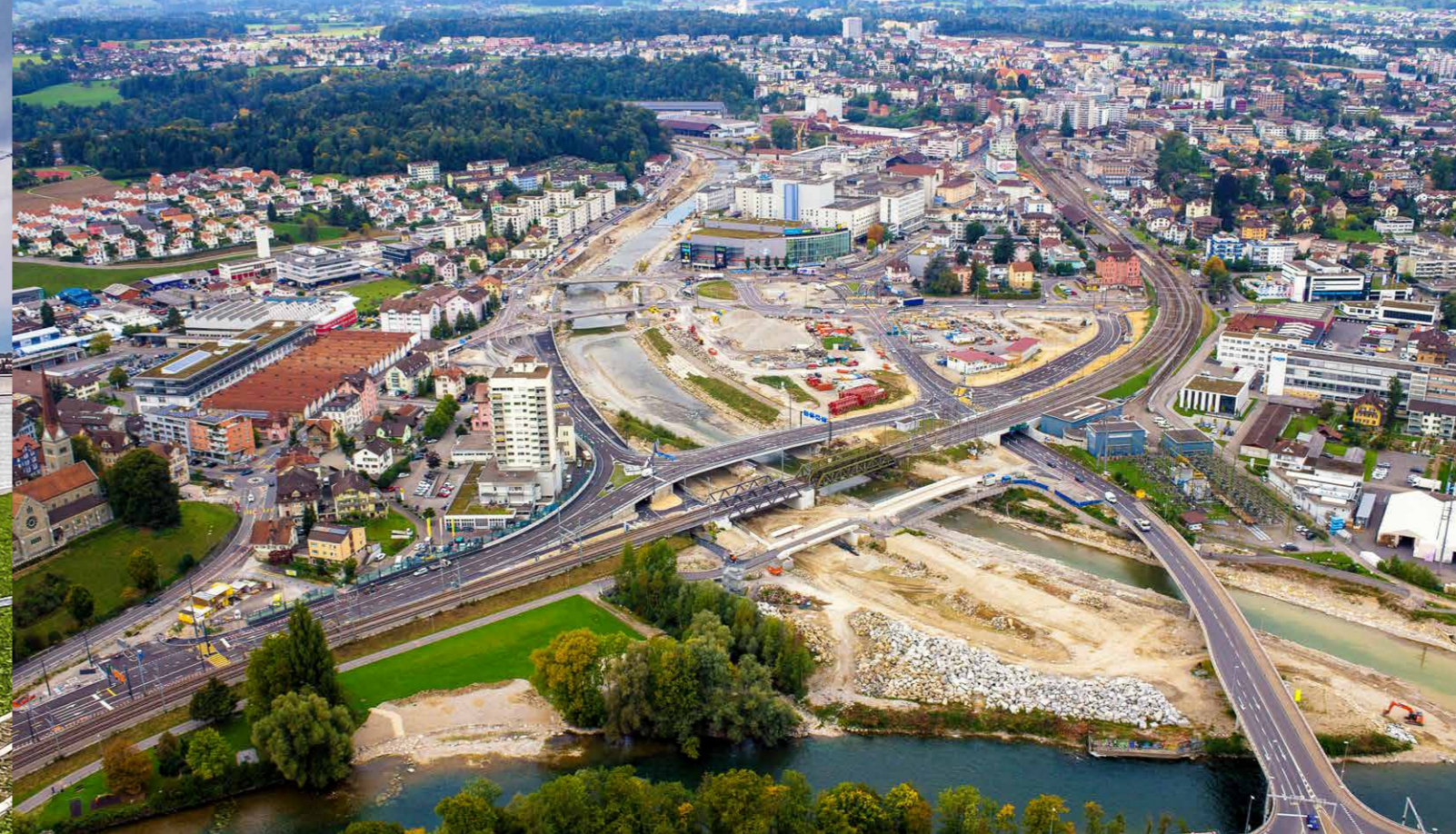
Das Entwicklungsgebiet Luzern Nord erstreckt sich über die Gemeindegrenze zwischen Emmenbrücke und Luzern. (Bild: Emch + Berger)
